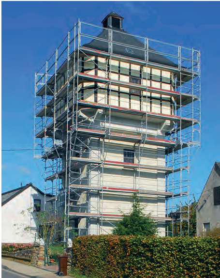
Umfangreiche Renovierungsarbeiten und Ausbau des Wasserturms, der jetzt auch für einige Veranstaltungen genutzt wird.
