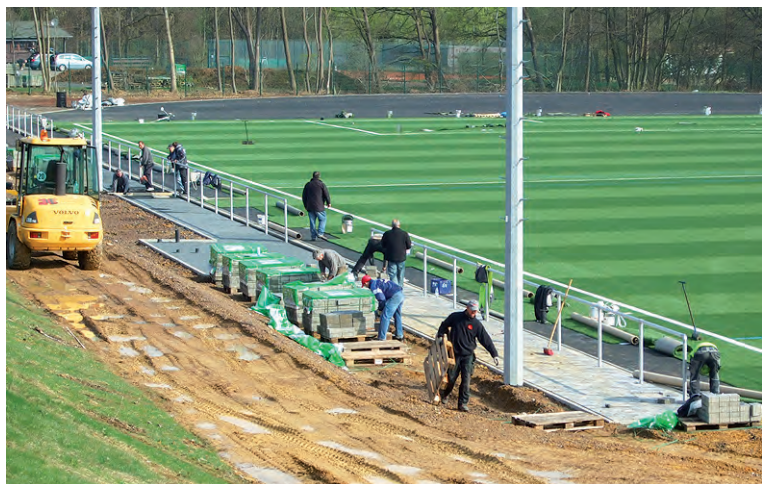
Umbau des Waldstadions mit Kunstrasenplatz und Laufbahn. Viele Vereinsmitglieder übernehmen einen großen Anteil der Arbeiten in ihrer Freizeit. Örtliche Unternehmen unterstützen uns.
